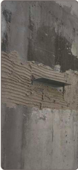
Fixation des équerres de guidage
