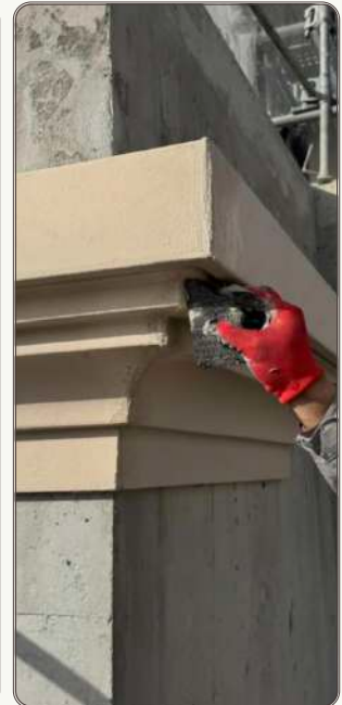
Traitement de la jonction à l'aide de la colle puis joint acrylique
