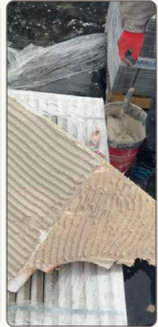
Traitement de la jonction à l'aide de la colle puis joint acrylique
