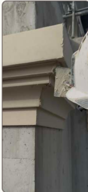
Traitement de la jonction à l'aide de la colle puis joint acrylique
